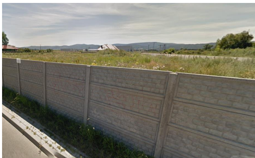
Fot. 48. Ogrodzenie przy ul. Brzegowej
