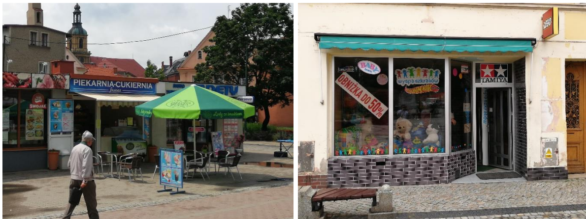
Fot. 22. Markiza przy ul. Marsz. J. Piłsudskiego i ul. Słowiańskiej
