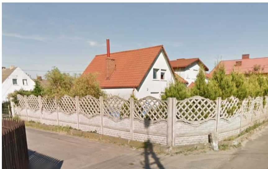
Fot. 49. Ogrodzenie przy ul. Wesołej
