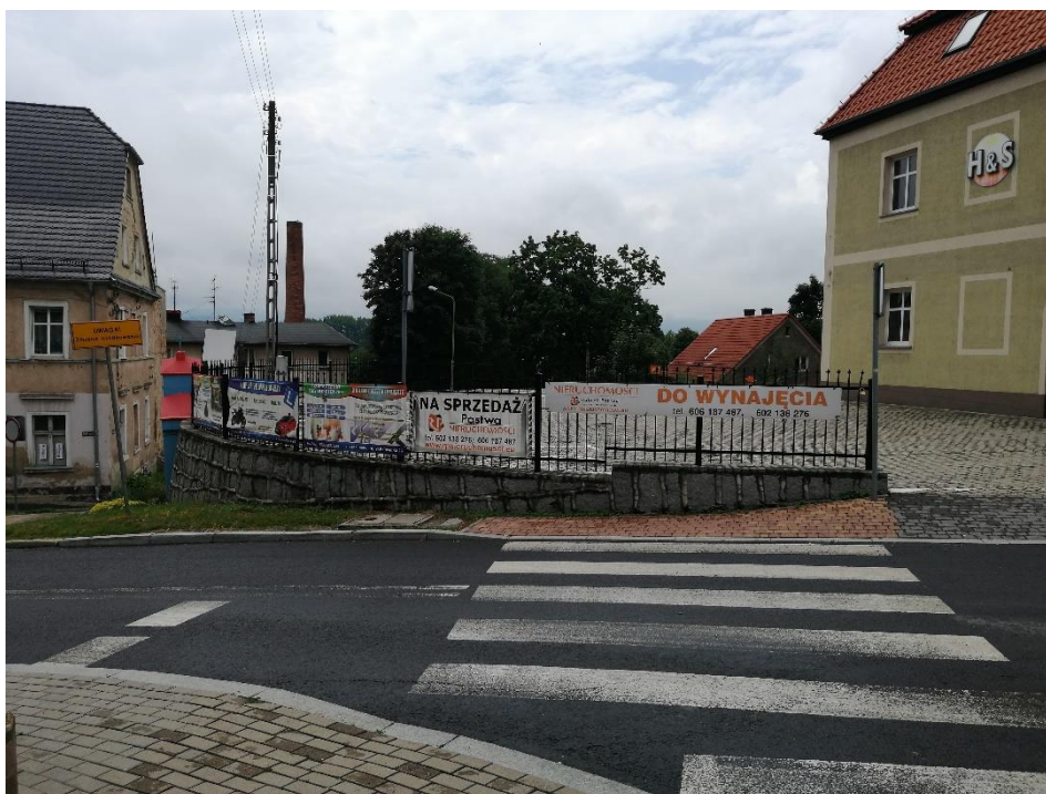
Fot. 44. Ogrodzenie przy ul. Prochowej i ul. Krasickiego
