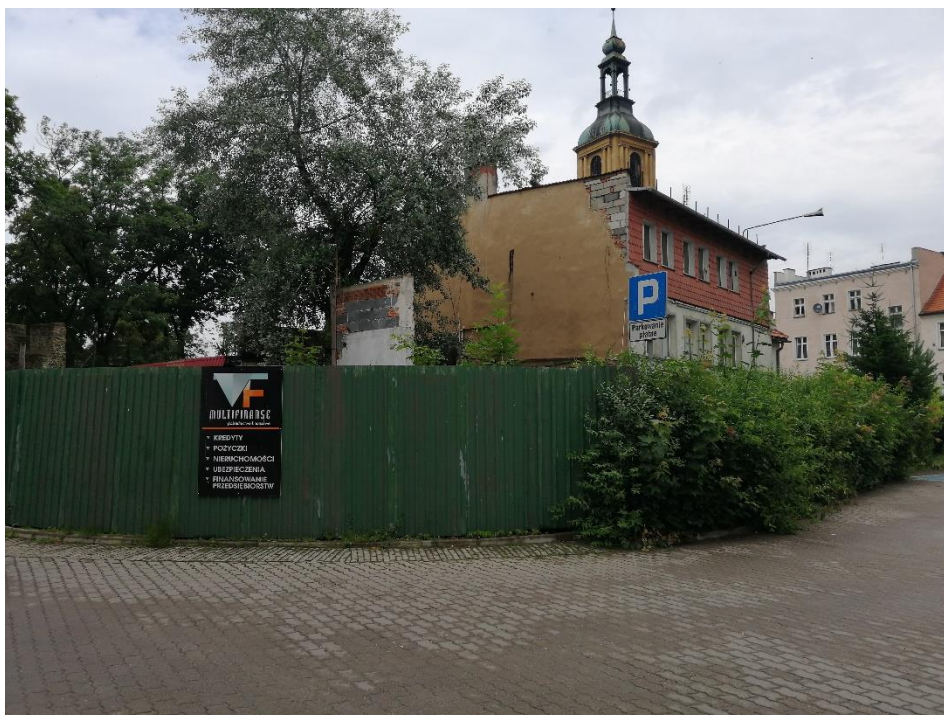
Fot. 40. Ogrodzenie pełne przy ul. Nowej
